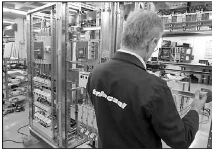
Un treballador de Telecsal a la planta de Cornellà
